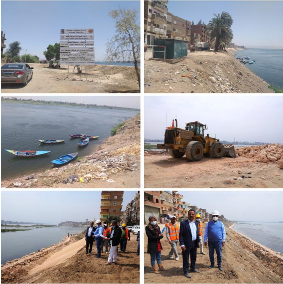
شكل (2-11): مجموعة صور فوتوغرافية توضح المنطقة محل الدراسة والتي تبلغ مساحتها (2340 متر) خط طولي موازي لنهر النيل مقابل مدينة أخميم ، وعملية تسليم الموقع لمقاولي التنفيذ ومتابعة مراحل التنفيذ ، كما توضح الصور المناطق السكنية المجاورة ، وتواجد مراكب صيد لصيد الأسماك النيلية بالمنطقة (البلطي والانس والبياض والقرموط والبويزة) وغيرها من الأنواع.
