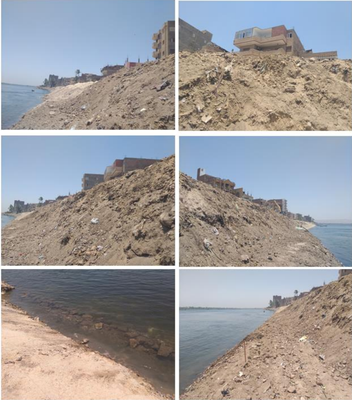
شكل (2-14): مجموعة صور فوتوغرافية للمنطقة محل الدراسة توضح إرتفاع الطريق عن خط مياه النيل بحوالي (15 - 20 م) ، كما توضح الصور شكل الميول للتربة والتي يتم تمهيدها وضبط الميول ودكها وإضافة الحصى بالمناطق التي تغمرها المياه أو إضافة الرمال بالمناطق المرتفعة بسحب كل منطقة تمهيدا لعمليات التدبير للمنطقة.
