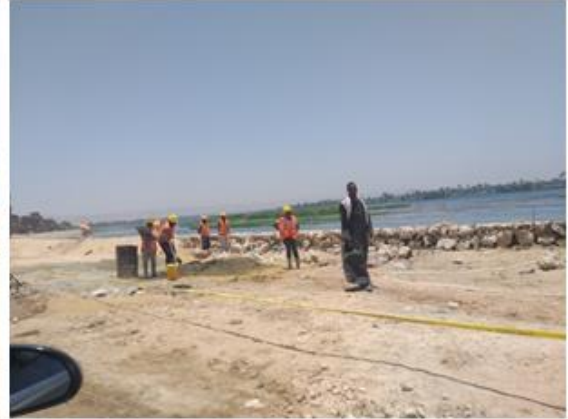
شكل (15-2): مجموعة صور فوتوغرافية للمنطقة محل الدراسة توضح مناطق تشوين الرمال والأحجار (الحجر العيسوي) والمستخدم في عملية التدبير ، والإلتزام بمعدات الوقاية والحماية ، وشد شريط فاصل يحدد المنطقة ويعزلها عن الطريق بما لا يعيق حركة المركبات أو الأفراد وبما لا يؤثر على السكان المحليين.
