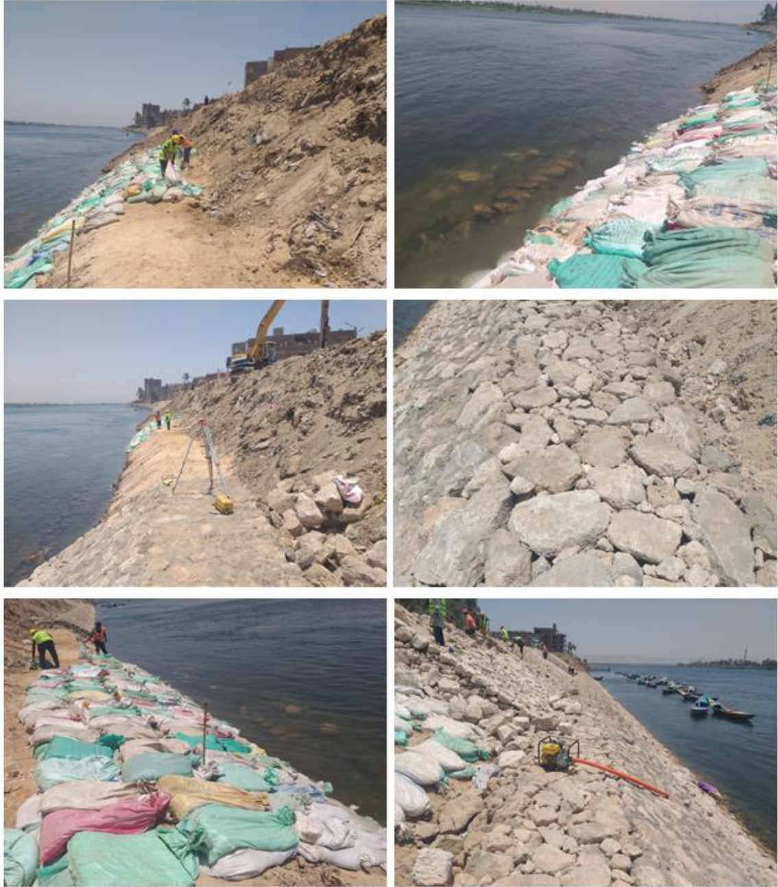
شكل (17-2): مجموعة صور فوتوغرافية للمنطقة محل الدراسة توضح استخدام الحفار لإنزال الحجر لمناطق التدبيش (الحجر العيسوس) بحسب المواصفات الفنية لأعمال حماية جوانب نهر النيل (معهد بحوث النيل - المركز القومي لبحوث المياه - وزارة الموارد المائية والري) ، وعملية دك وإضافة طبقة عازلة من الرمال أو الحجر أسفل مناطق التدبيش ، والإلتزام بمعدات الوقاية والحماية.
