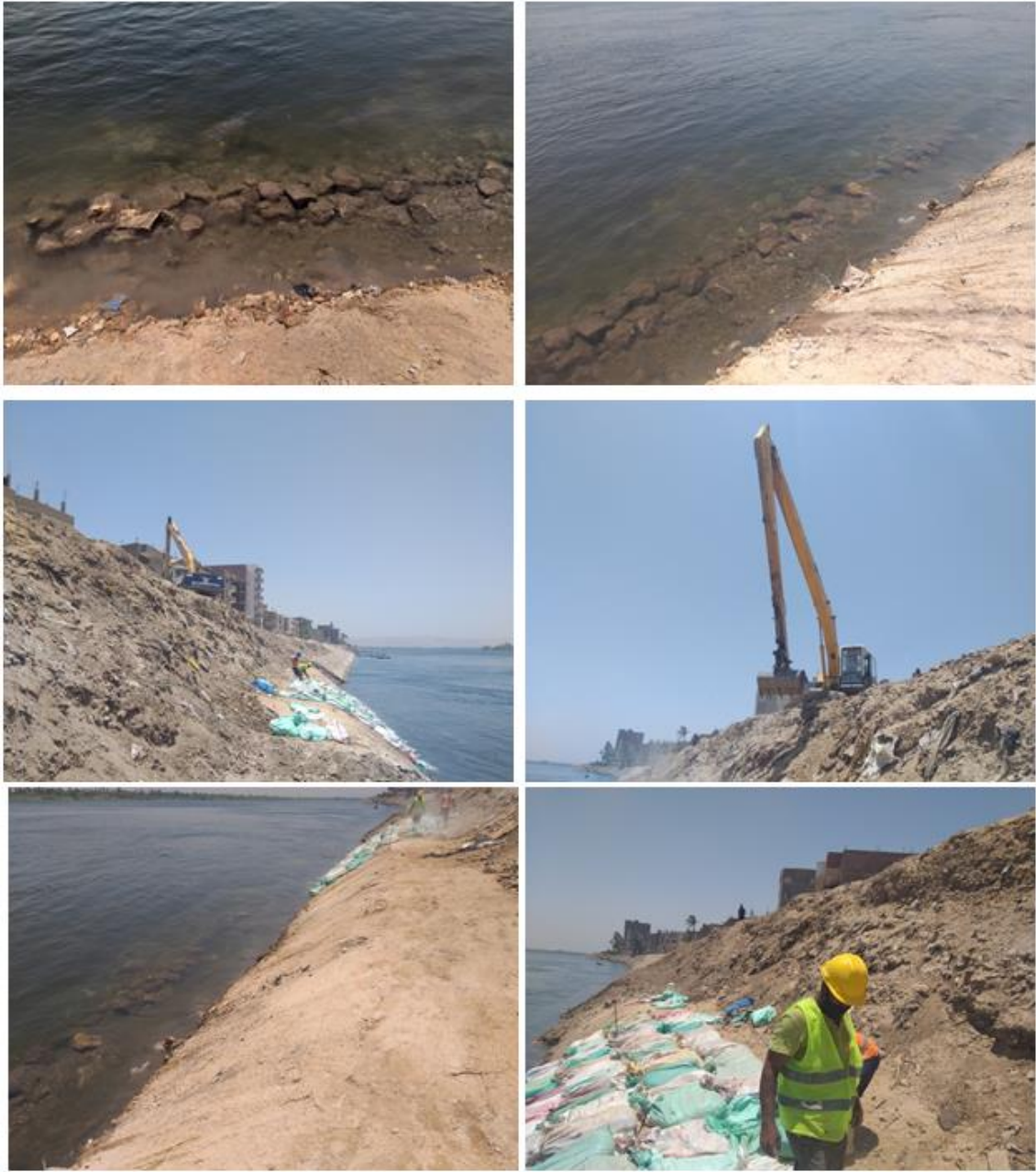
شكل (16-2): مجموعة صور فوتوغرافية للمنطقة محل الدراسة توضح إستخدام الحفارات في عمليات تمهيد مناطق التدبيش وتنزيل الحجر العيسوس لمناطق المياه أسفل مناطق التدبيش بحسب المواصفات الفنية لأعمال حماية جوانب نهر النيل (معهد بحوث النيل – المركز القومي لبحوث المياه – وزارة الموارد المائية والري) ، وعملية دك وإضافة طبقة عازلة من الرمال أو الحجر أسفل مناطق التدبيش ، والإلتزام بمعدات الوقاية والحماية.
