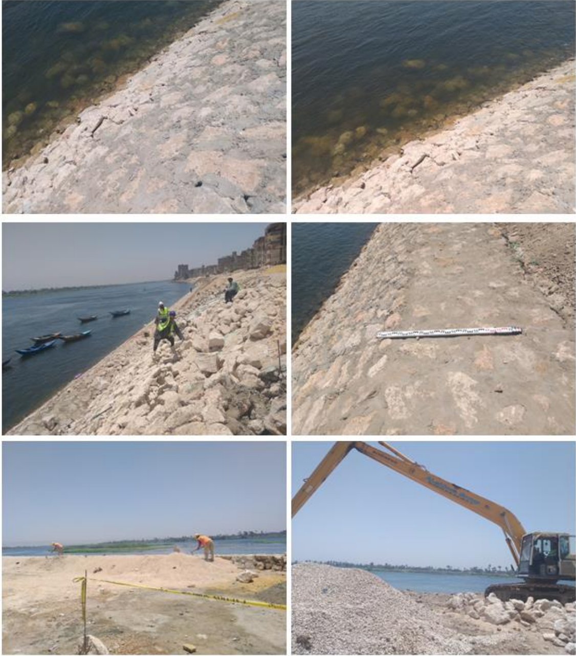
شكل (18-2): مجموعة صور فوتوغرافية للمنطقة محل الدراسة توضح استخدام الحفار لإنزال الحجر لمناطق التدبيش (الحجر العيسوس) بحسب المواصفات الفنية لأعمال حماية جوانب نهر النيل (معهد بحوث النيل - المركز القومي لبحوث المياه - وزارة الموارد المائية والري) ، وعملية تثبيت الأحجار وعملية التكهيل لسد الفجوات باستخدام المونه (رمل + أسمنت) ، وحتى الشكل النهائي لعملية التدبيش ، مع الإلتزام بمعدات الوقاية والحماية الشخصية لجميع العاملين بالمشروع.
