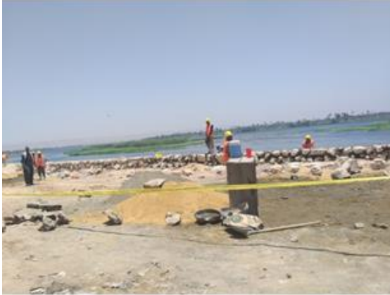
شكل (15-2): مجموعة صور فوتوغرافية للمنطقة محل الدراسة توضح مناطق تشوين الرمال والأحجار (الحجر العيسوي) والمستخدم في عملية التدبير ، والإلتزام بمعدات الوقاية والحماية ، وشد شريط فاصل يحدد المنطقة ويعزلها عن الطريق بما لا يعيق حركة المركبات أو الأفراد وبما لا يؤثر على السكان المحليين.
