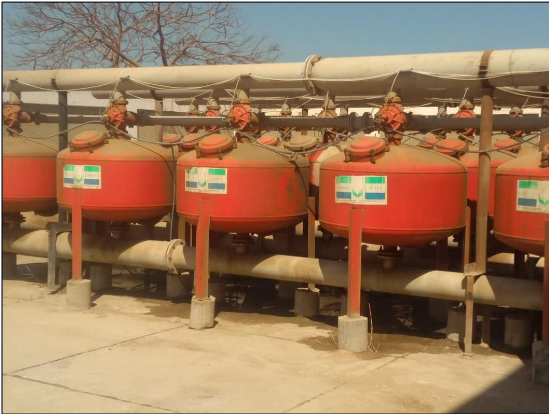
شكل (٢-٣) يوضح فلاتر التنقية بالمزرعة ( Gravel filter )
