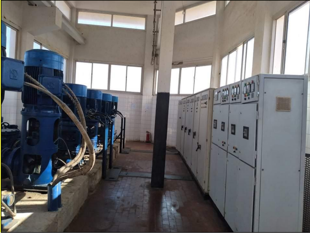
شكل (١-٣) يوضح عنبر الطلمبات لرفع المياه من بيارة التجميع الى الفلاتر
