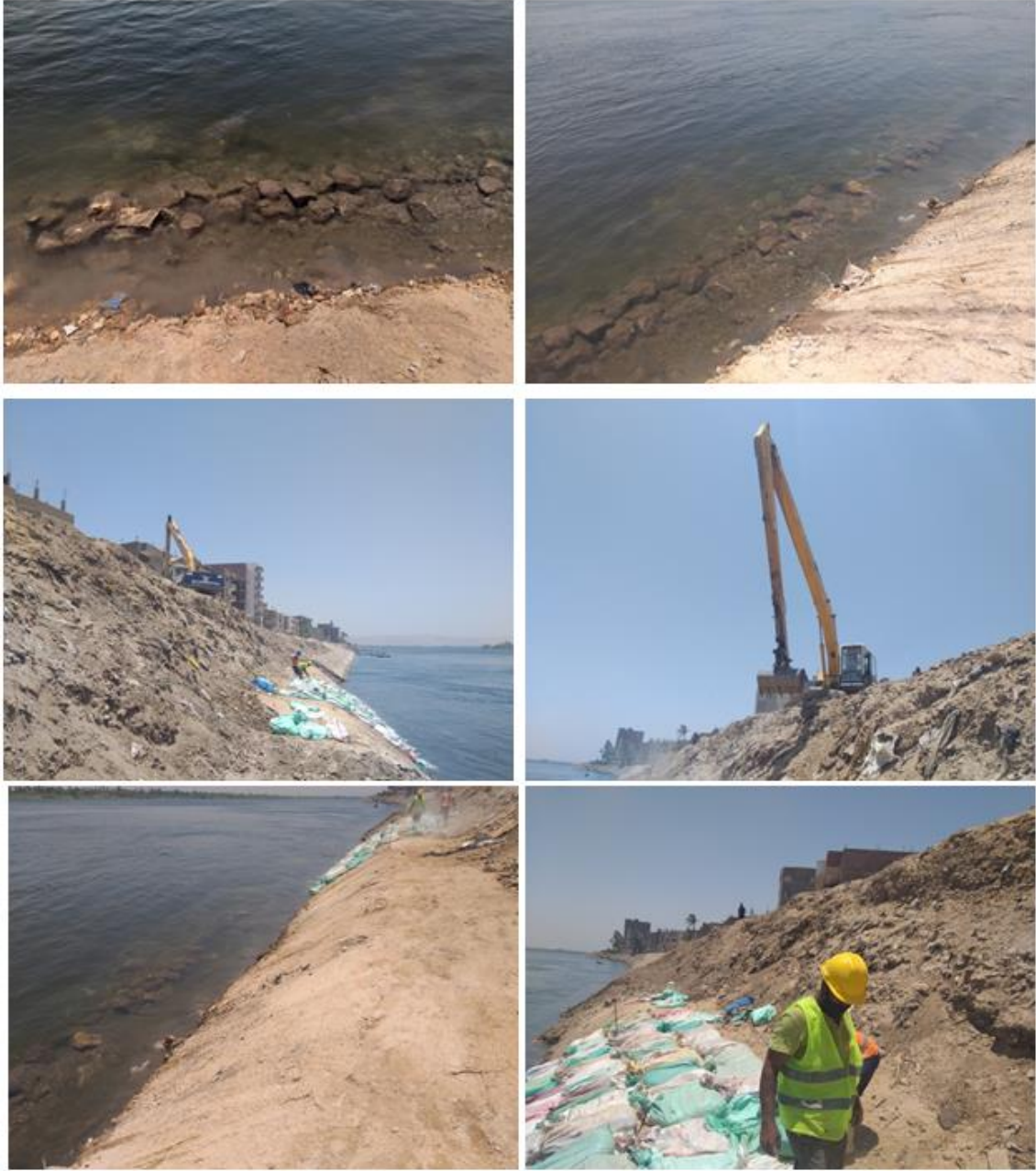
شكل (2-15): مجموعة صور فوتوغرافية للمنطقة محل الدراسة توضح الوضع الحالي وأعمال التطهير لجوانب النيل باستخدام الحفارات ومناطق التدبيش القديمة لحماية جوانب نهر النيل بكورنيش أخميم.
