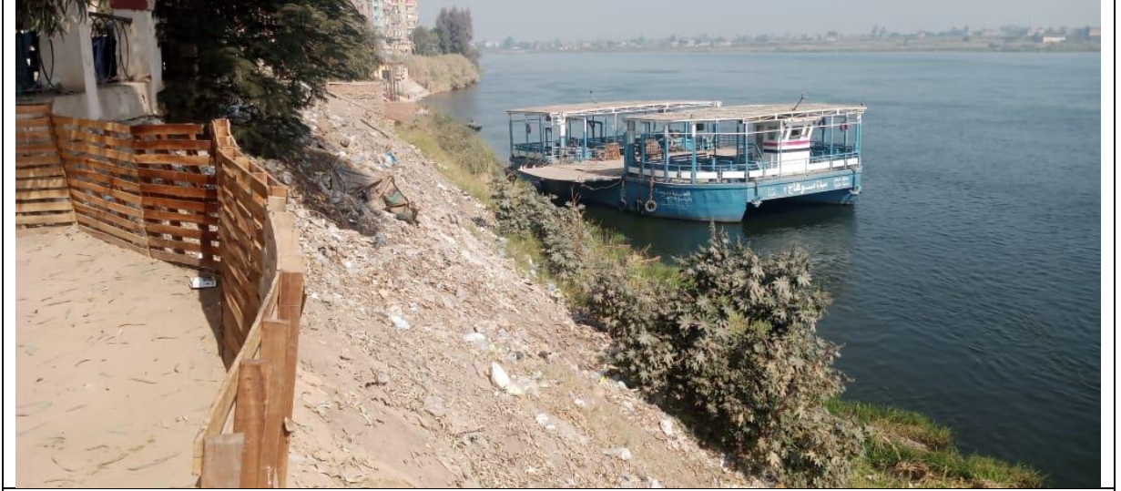
شكل (2-3): منطقة التدبيش التي ستم بالمرسى بطول 180 متر (الجزء الجنوبي من المرسى القائم)
