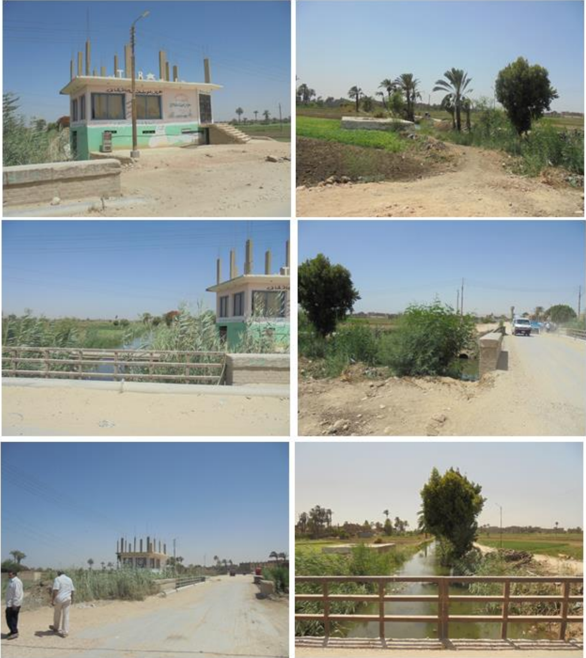
شكل رقم (2-9): مجموعة صور فوتوغرافية توضح المنطقة محل الدراسة حيث مشروع (إنشاء كوبري ك 19 شرق الكسرة - ضمن توسعة طريق الحوافة بقرية العوامر - بيت داوود - جرجا) قرية العوامر بحري بمركز جرجا ، كما توضح الصور أن المنطقة ريفية معظم سكانها يعملون بالزراعة.
